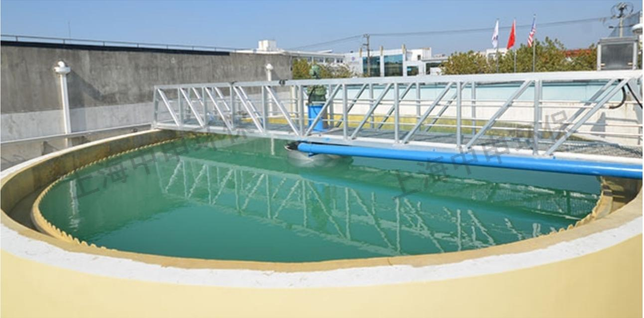
周边传动刮泥机主要由工作桥与走道板、端梁及驱动机构、中心支座及集电装置、刮渣耙、刮板组合、撇渣装置、稳流筒、排渣及溢流装置、电控系统等部件组成。主要结构：工作桥采用型钢焊接成桁架结构，上铺防腐钢格走道板，工作桥两侧桁架兼栏杆作用，同时设有电线穿线管。工作桥根据长度分段制造后再用螺栓联接，一端与端梁拼装并设爬梯（两端均设爬梯），工作桥另一端与中心支座铰支连接。制造时工作桥比较大允许挠度为 $L/700$ 需保证足够的强度支撑正常负荷。工作桥的组装拼装焊接要求严格按照JB/ZQ4000.3-86焊接件通用技术条件执行。端梁上安装的驱动装置采用平行轴斜齿轮式减速机（双驱动减速机及电机）。并设过力矩保护装置，过力矩可调节，使刮泥机运行安全可靠。
